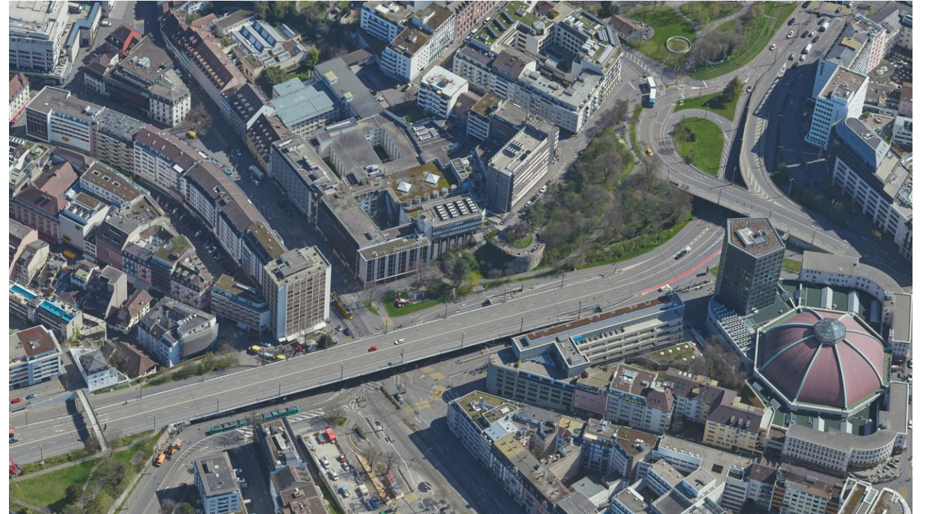
Steinertor und Bollwerk Basel, 2019
