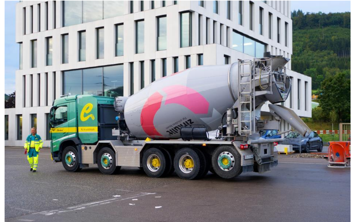
Zirkulit AG, Anlieferung Beton zur Vorfertigung Stahlton, Foto: ROK Architekten
