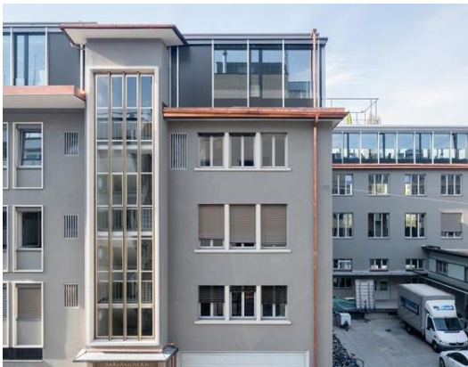
Gebäude weinternutzen Sanierung/Aufstockung Büro, Zürich Meier Hug Architekten
