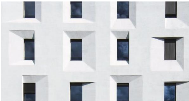
Gut gedämmte Gebäude mit wenig Wärmebedarf
