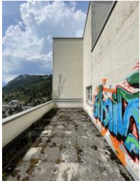
Süd-Westseite Ebene 7 Getreidesilo 1939 / 1969
