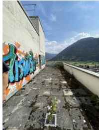
Süd-Westseite Ebene 7 Getreidesilo 1939
