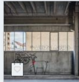
Unterzug Stahlbeton / I- Träger 9.20m
