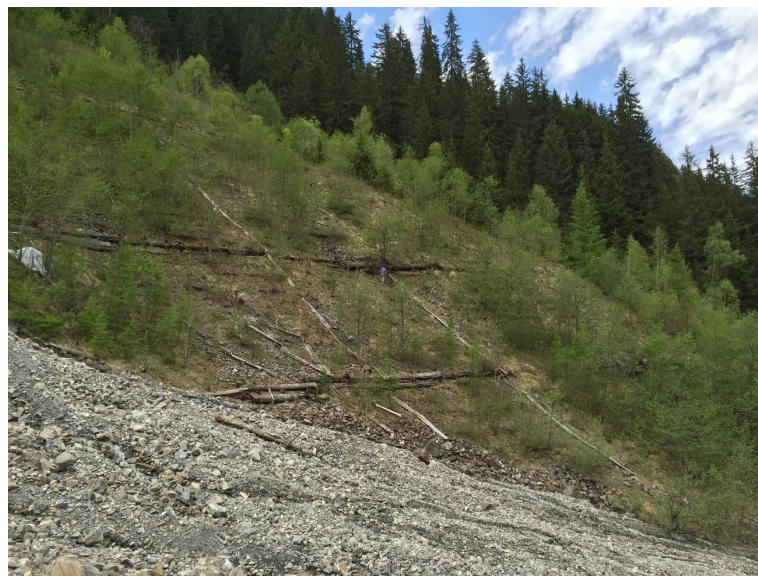
Mit Holz verbaute und bepflanzte Grossrutschung in einem Gerinneinhang
