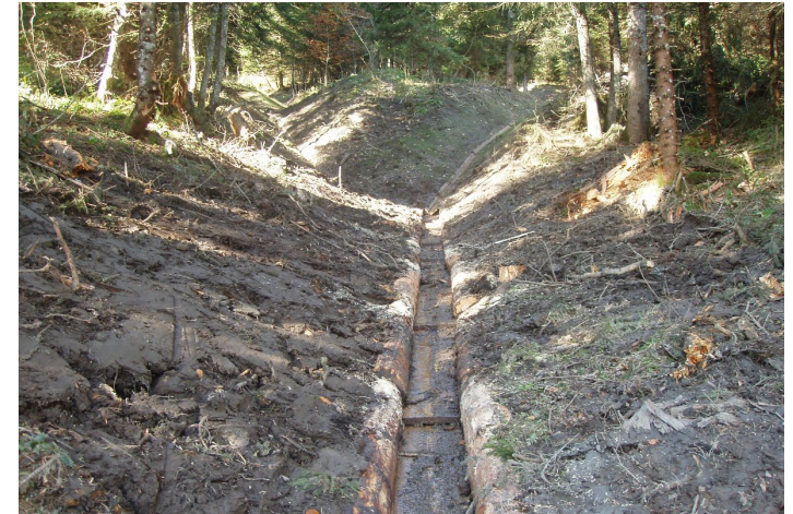
Entwässerungskänel (oben) und Hangstabilisierungsschwellen mit Holzwolle- Erosionsschutz (unten)
