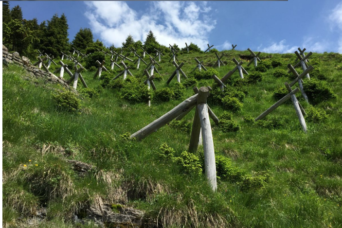
Temporärer Anriss- (oben) und Gleitschneeverbau (unten)
