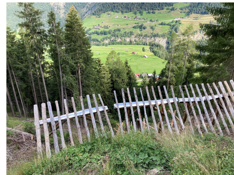
Schneerechen Typ SLF aus dauerhafter, Tessiner Edelkastanie
