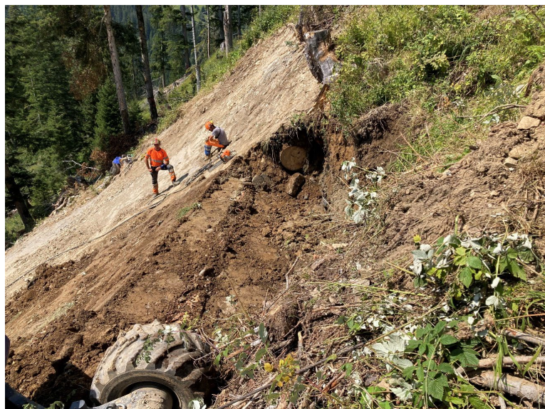
Vollständig eingedeckte Holzkasten zur Rutschungsstabilisierung. Erosionsschutz durch Holzwollematten und Stecklinge zur langfristigen Stabilisation sind noch ausstehend.
