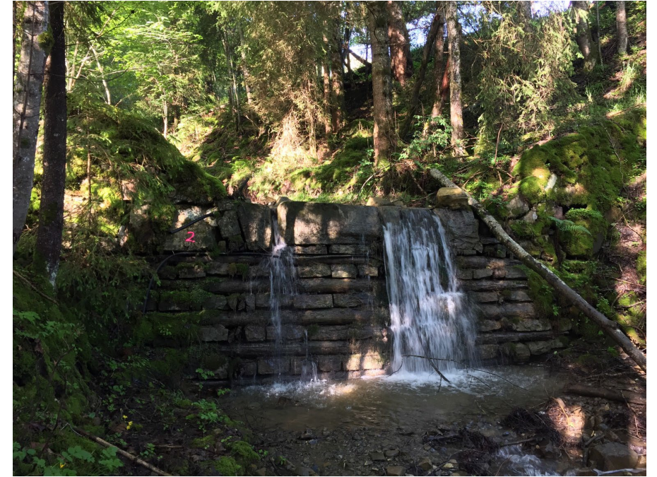
Sperrbauwerk aus Holz/Stein kombiniert, nachweislich 1945 erbaut.
