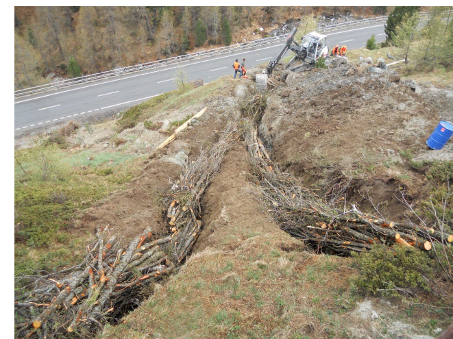
Hangentwässerung durch Totholzfaschinen
