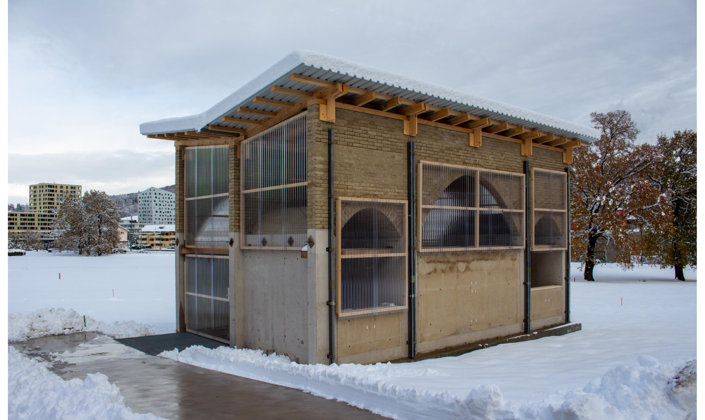
Pavillon Manal, Horw Arbeiten durch Marti AG; Bilderrechte Oxara
