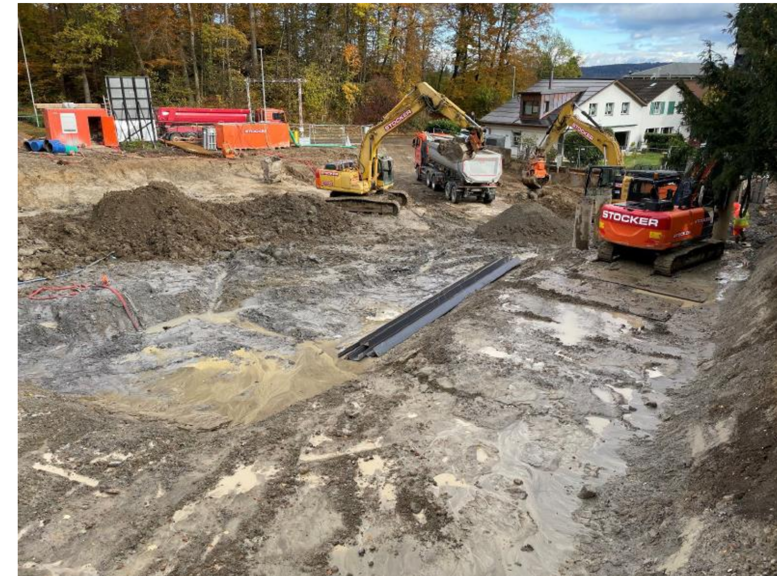
Baustelle Schweiz, Hilgert
