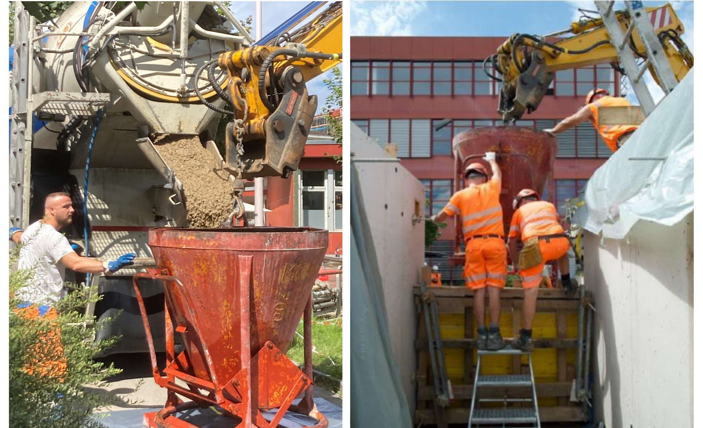
Gusslehm Nossim für Pavillon Manal @ HSLU Campus Arbeiten durch Marti AG; Bilderrechte Oxara
