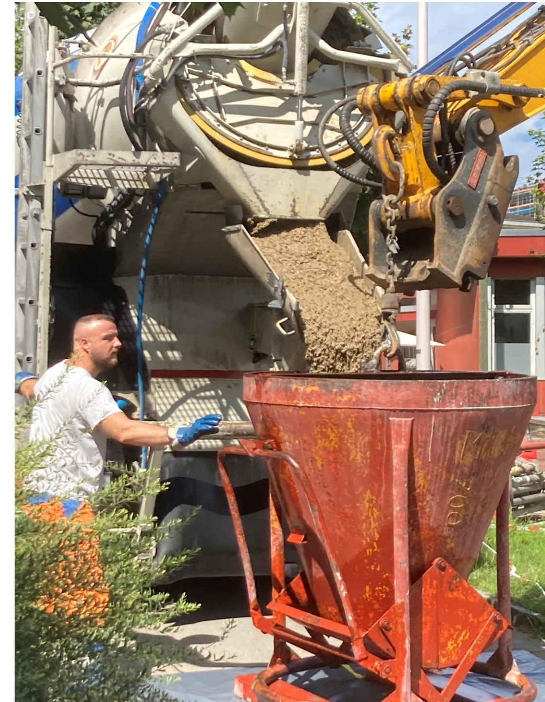
Gusslehm Nossim für Pavillon Manal @ HSLU Campus Arbeiten durch Marti AG; Bilderrechte Oxara
