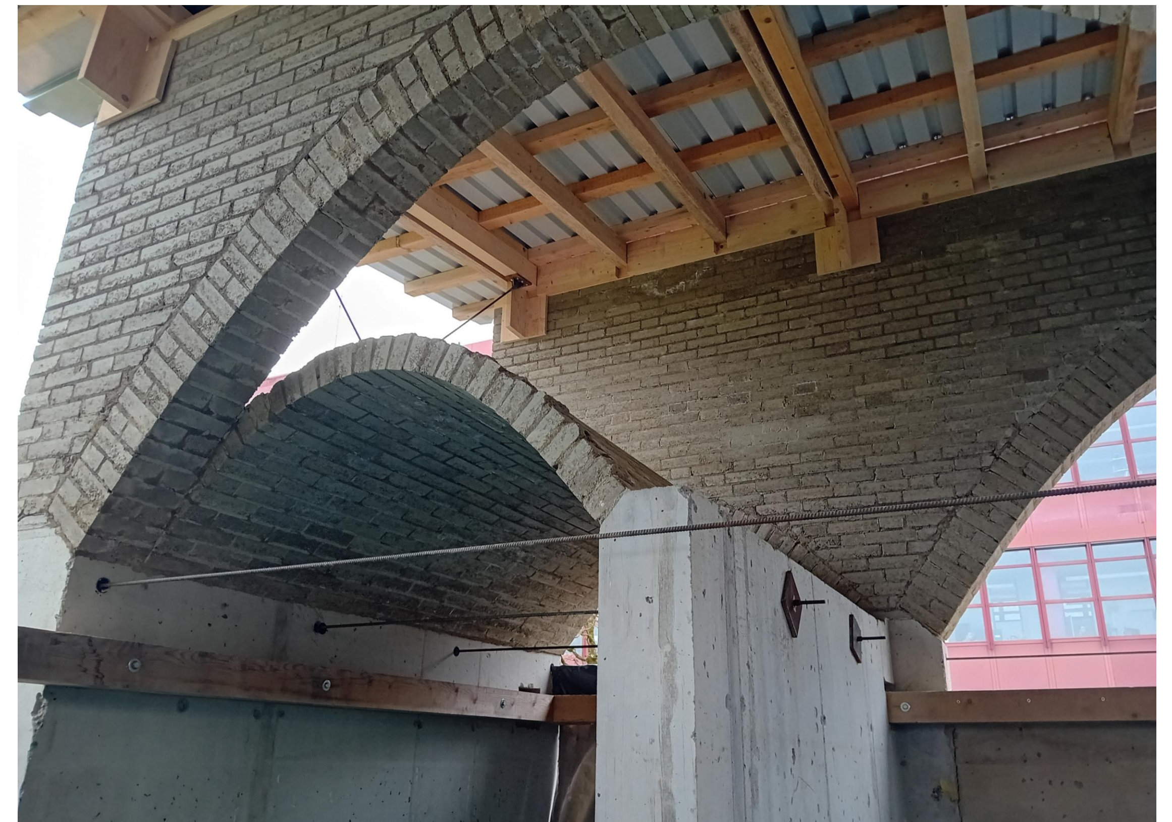
Pavillon Manal Lehmsteingewölbe
