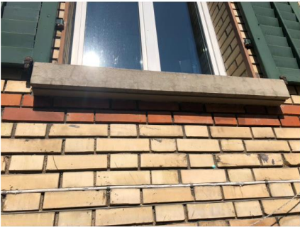
Fensterbretter Gebäude Schaffhauserstrasse
