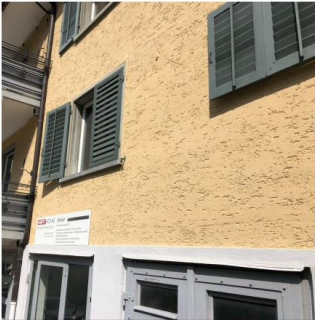
Fensterbretter Gebäude Oerlikonerstrasse
