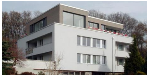
Sanierung/Aufstockung MFH, Zürich Stahel Ehrsam Architekten
