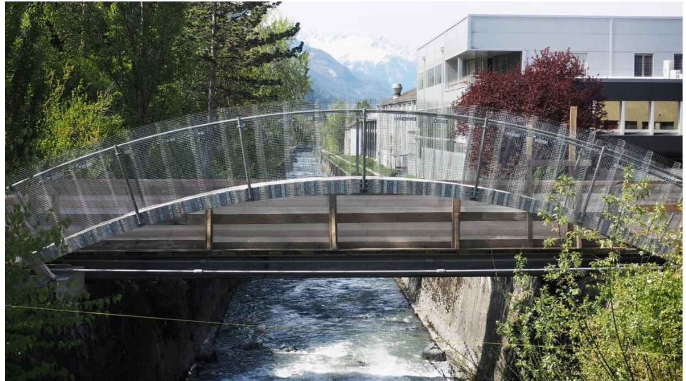
Fussgängerbrücke aus ReUse Beton-Elementen. EPFL, Structural Xploration Lab, Prof. C. Fivet
