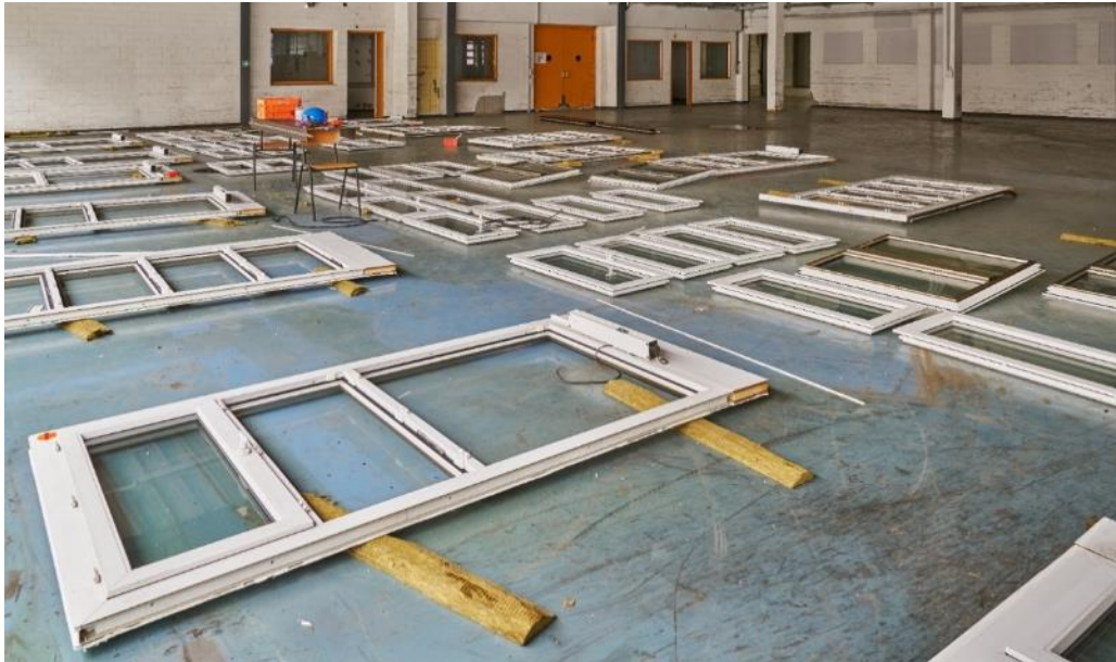
Abb: Rückbau einer ehemaligen Druckerei in Winterthur. © Martin Zeller
