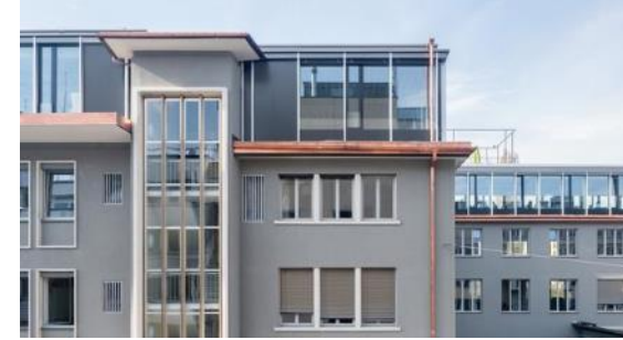
Sanierung/Aufstockung Büro, Zürich Meier Hug Architekten
