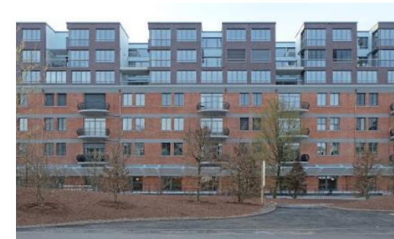
Aufstockung Freilager Meili & Peter Architekten
