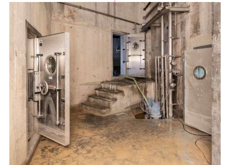
St. Gallen: Unterirdisches Retentionsbecken
