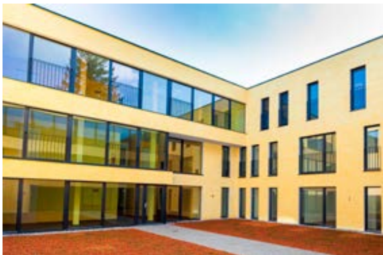
Referenzbild: Erfolgreiche Umsetzung von EgoKiefer Farb- und Dekorfolien in der Praxis (Wohn- und Gewerbegebäude «Haus am Kesselbach» in Altstätten).
